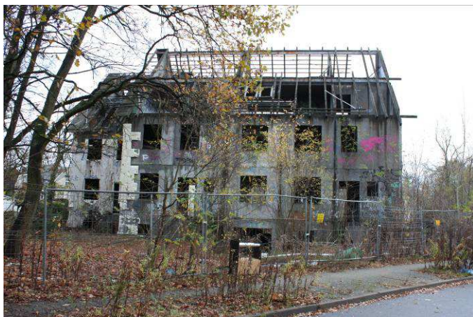
Standfeste Bauruine in der Raisdorfer Straße
