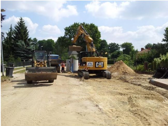
Baufreiheit für den Ausbau Kieferndamm
