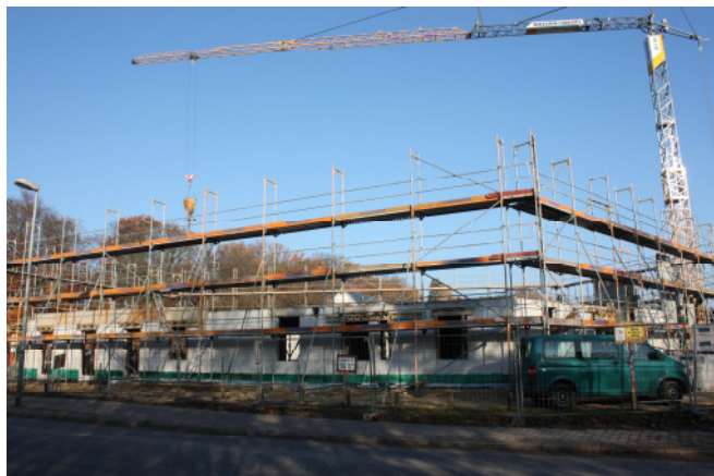
Stetiger Baufortschritt beim Rathausneubau.
