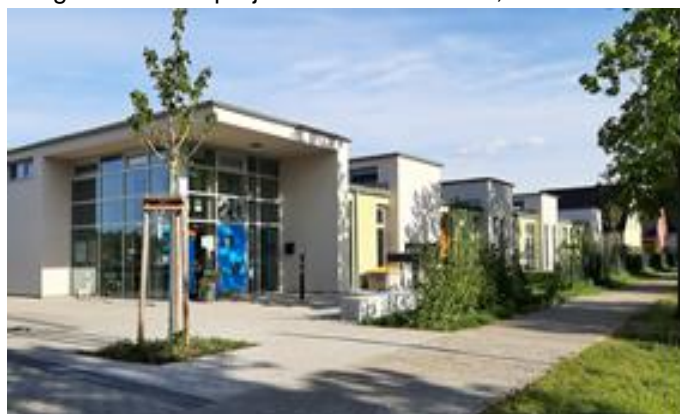
Neubau Kita Jägerstraße
