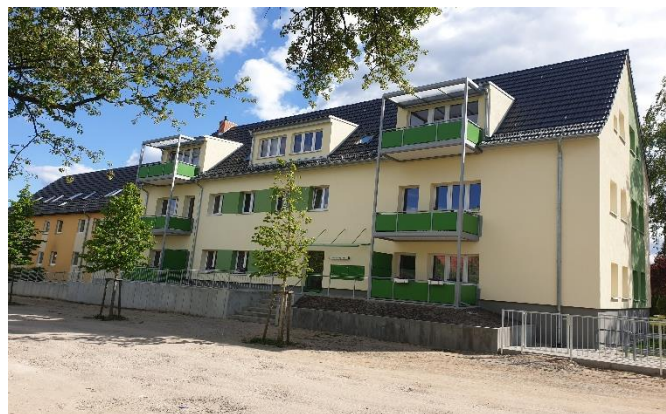
Kommunaler Wohnungsbau Bunzelweg 19D
